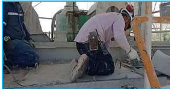
Foto No.14: Instalación de placas guillotinas
