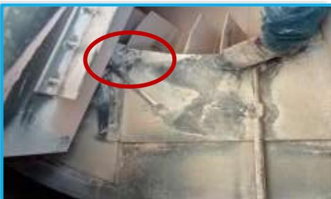
Foto No.17: Soldar soleras guías
