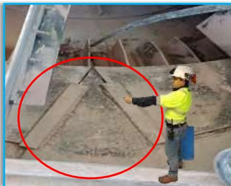
Foto No.11: Placa Triangular y Solera
