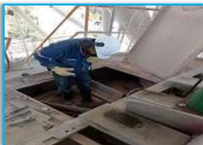
Foto No.18: Soldar guías instaladas
